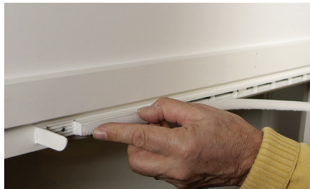
Elektrostaattisen allergeenisuodattimen vaihto
