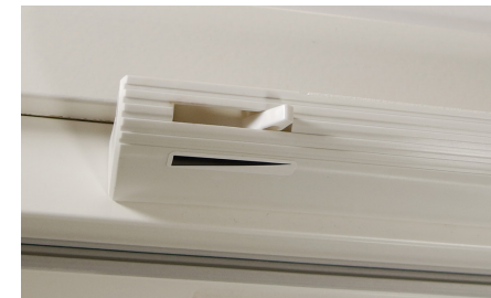
Ilmamäärän säädin on manuaalinen.
