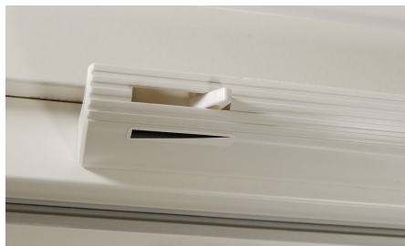
Ilmamäärän säädin on manuaalinen.
