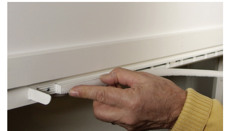
Elektrostaattisen allergeenisuodattimen vaihto
