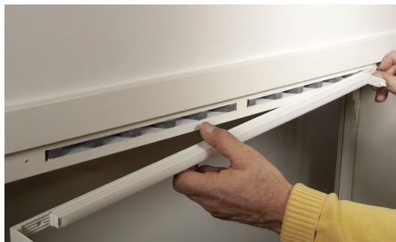
Ilmanottoakanavat suodatinkehysten takana
