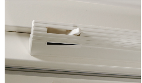
Ilmamääräsäädin on manuaalinen.
