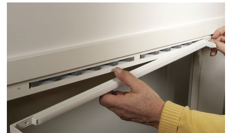
Ilmanottoakanavat suodatinkehysten takana
