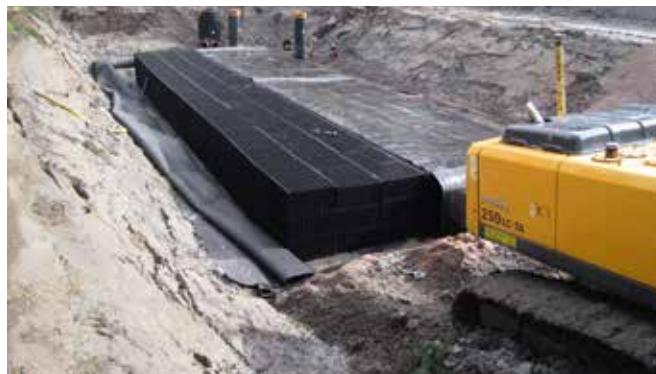
Hulevesikasetteja voidaan asentaa peräkkäin tai niitä voidaan pinota päällekkäin halutun kokoisen järjestelmän rakentamiseksi.
